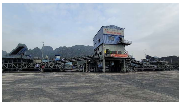
Kho cảng Km6 - Công ty Kho vận và Cảng Cẩm Phả được quy hoạch đồng bộ, chú trọng thực hiện tốt công tác môi trường
