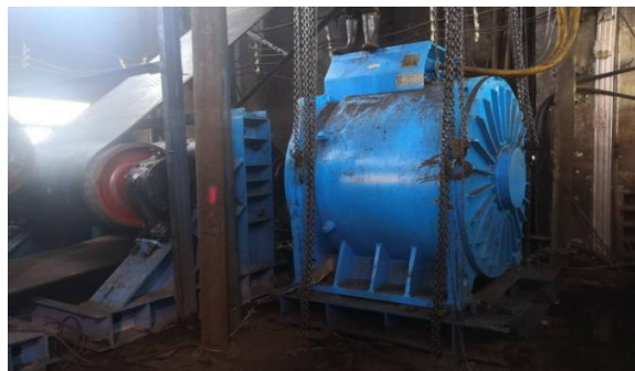
Hình 12. Động cơ LSPMSM kéo băng tải mỏ than Jinshen Ciyagou - Trung Quốc (2019)
