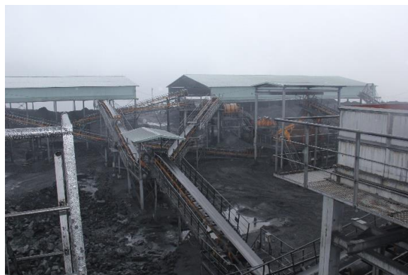
Hệ thống dây chuyền sàng tuyển than tại mức +45 - Công ty CP Than Cọc Sáu
