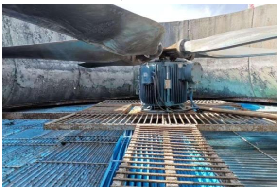
Hình 10: Động cơ LSPMSM của quạt tản nhiệt hệ thống phát điện Nhà máy Xi măng Pingliang Qilianshan (2019)
