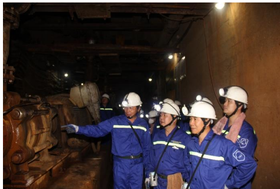
Đoàn công tác của Ủy ban QLVNN tại DN tham quan khu vực hầm bơm, trạm điện tại mức -140 m, được ví như trái tim của mỏ
