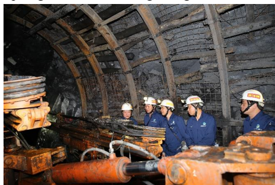
Lãnh đạo Tập đoàn kiểm tra thiết bị xe khoan 2 cần của Công ty Than Nam Mầu nghiên cứu cải hoán, chế tạo đáp ứng cho sản xuất than hầm lò
