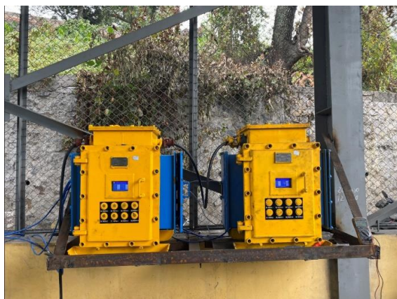
Hình 4: Tủ điều khiển giám sát trạm nạp lắp đặt tại hiện trường
