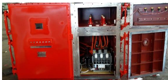
Hình 4. Bộ khởi động mềm trung thế phòng nổ IEMM-MVS-6000/200 (400)
