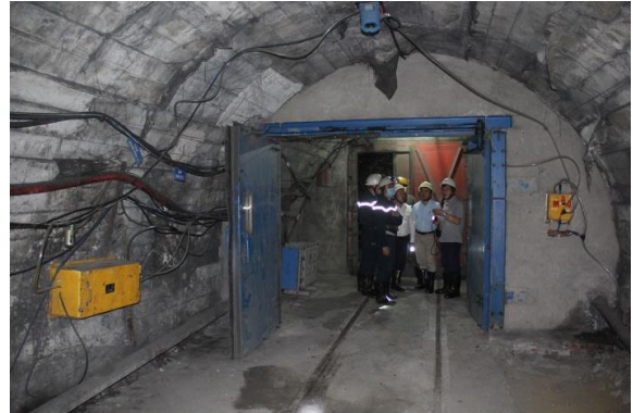
Đoàn công tác đi kiểm tra thực tế sản phẩm Cổng gió tự động được lắp đặt và chạy thử nghiệm tại cửa lò +17 Khu Tân Lập thuộc Công ty Than Hạ Long - TKV
