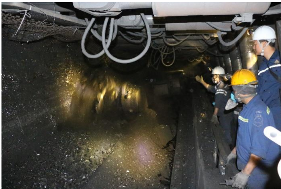
Lò chợ CGH công suất 1,2 triệu tấn than/năm của Công ty CP Than Hà Lâm
