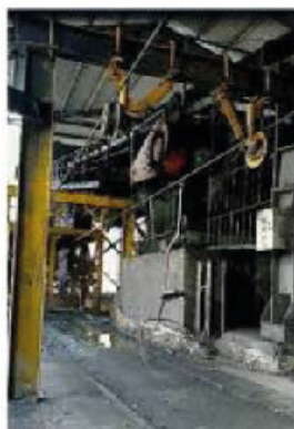
Thiết bị lắp tại mỏ
