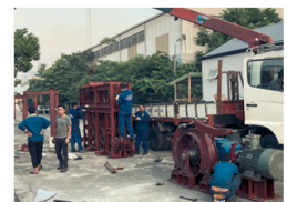
Lắp đặt tại xưởng
