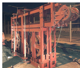
Trạm căng cáp
