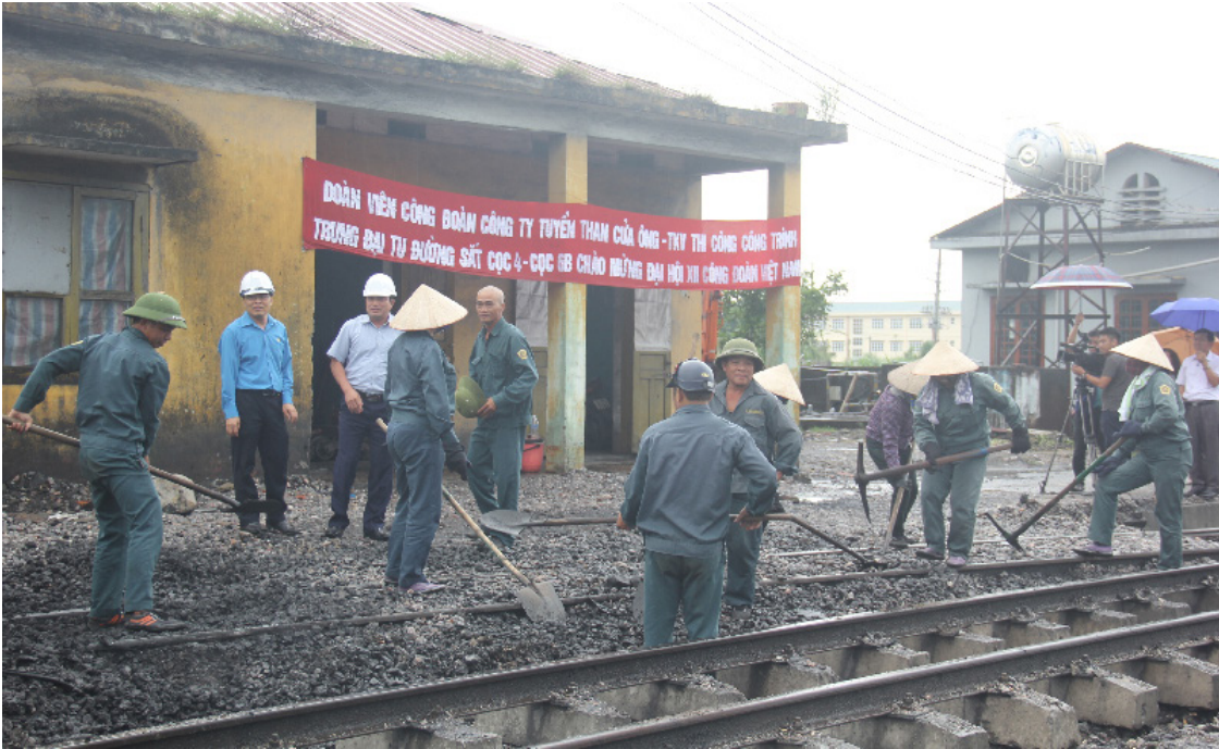
Công trình Trung đại tu tuyến đường sắt cọc 4 - cọc 6B của CNLD Phân xưởng Đường sắt - Công ty Tuyển than Cửa Ông
