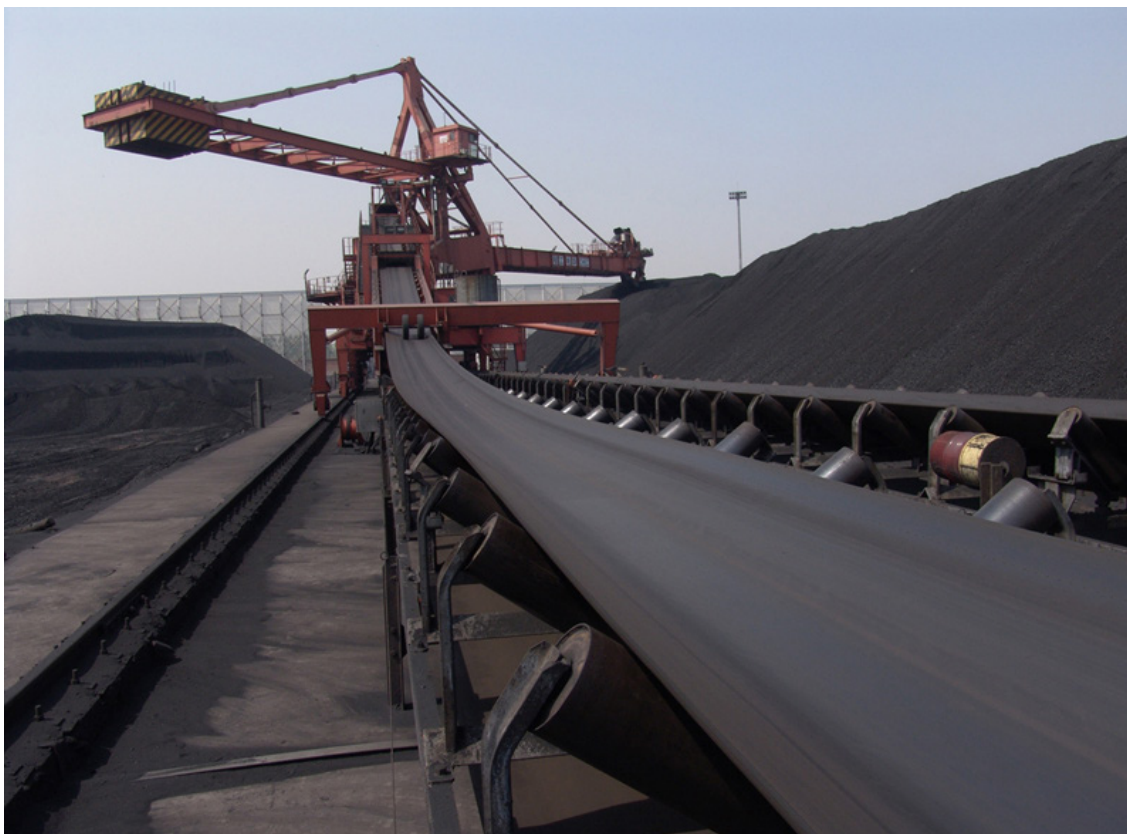
Nhiều dây chuyền sàng tuyển, bốc rót than tại Công ty Tuyển than Cửa Ông đã được tự động hóa. Ảnh: CTV
