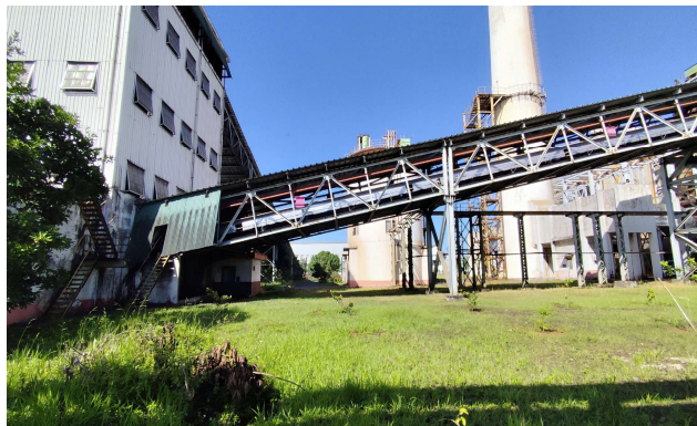
Hình 6. Vị trí đề xuất lắp đặt hệ thống phân tích than trực tuyến PGNAA tại Nhà máy Alumin Tân Rai
