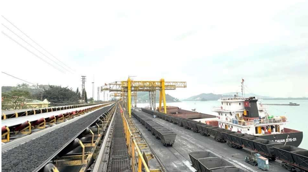
Dây chuyền vận chuyển, bốc rót, tiêu thụ than hiện đại tại Công ty Tuyển than Cửa Ông - TKV
