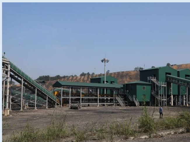
Xưởng sàng 2,5 triệu tấn than/năm Công ty Cổ phần Than Hà Tu - Vinacomin
