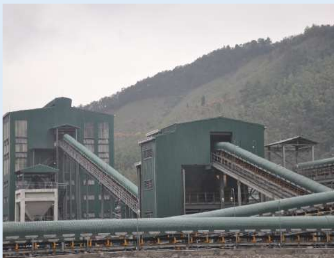
Nhà máy Sàng tuyển than Vàng Danh 2: Công suất thiết kế 2 triệu tấn than/năm
