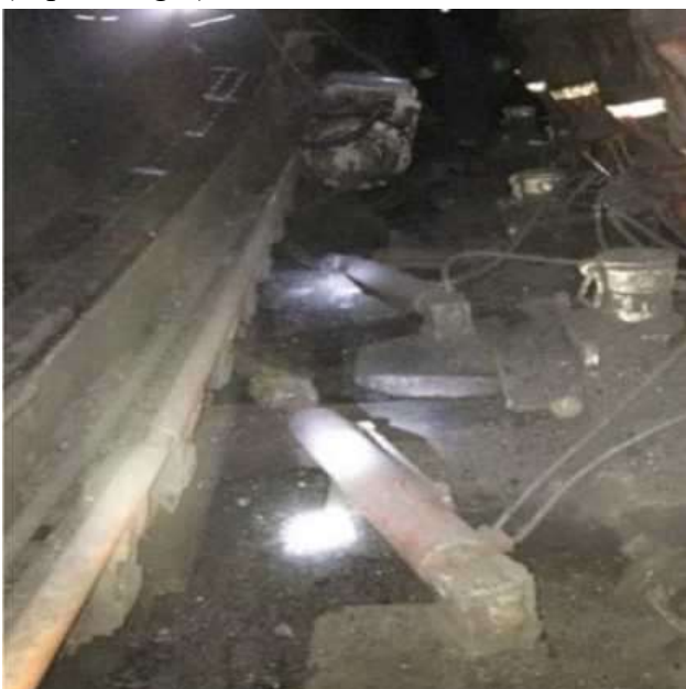
Hình 11. Hệ thống chống trôi máng cào
