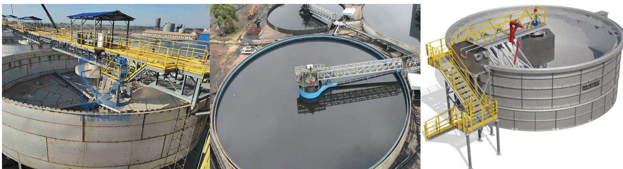
Hình 1: Bể cô đặc cào tròn và mô hình cấu tạo điển hình
