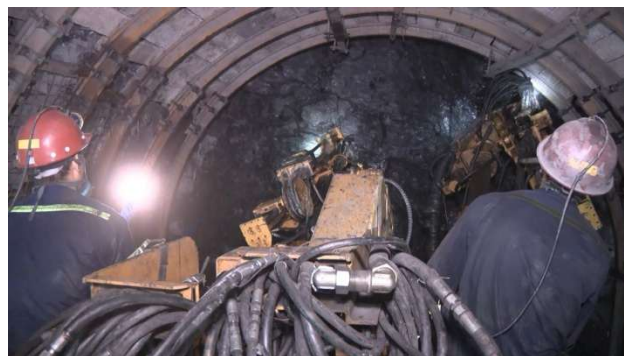
Hình 3. Xe khoan tự hành 2 cần tại gương đào Công ty Than Nam Mẫu
