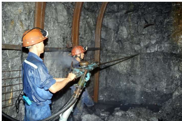
Hình 1. Công tác khoan - nổ mìn thủ công sử dụng máy khoan cầm tay công suất lớn
